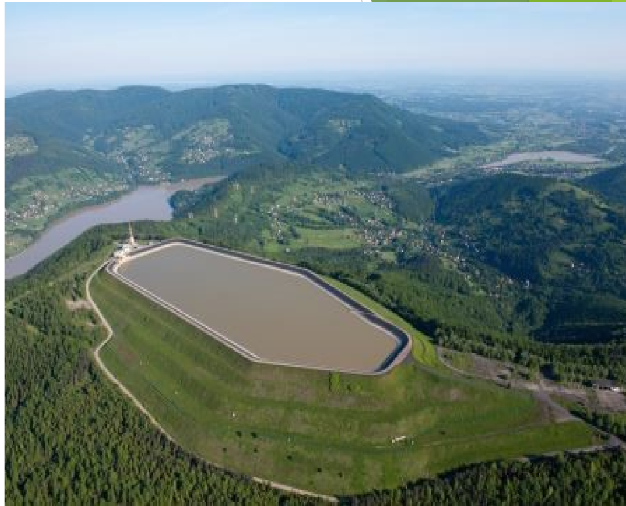
Elektrownia szczytowo-pompowa górny zbiornik Góra Żar
